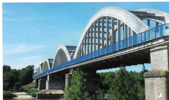
Élargissement du pont sur la Loire à Muides-sur-Loire.
